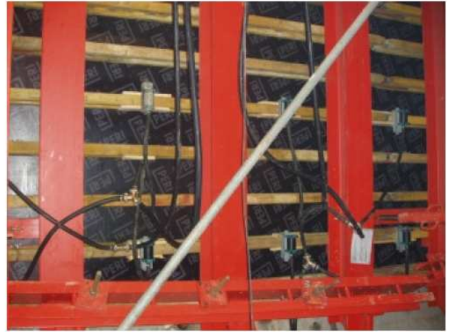
Perde kalıbına takılmış dış vibratörler
