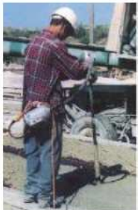
Dalgıç vibratör uygulaması
