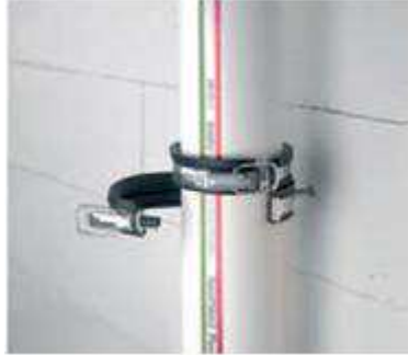
Resim 1.6: PVC borunun metal kelepçe ile sabitlenmesi
