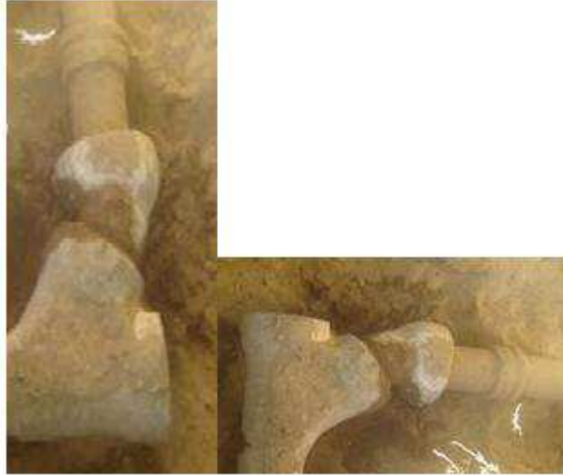
Resim 5.1: PVC borunun kanalizasyona bağlanması
