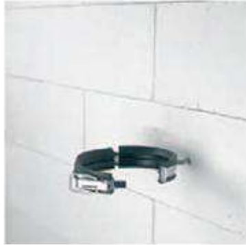
Resim 1.5: PVC boru için metal kelepçenin duvara montajı
