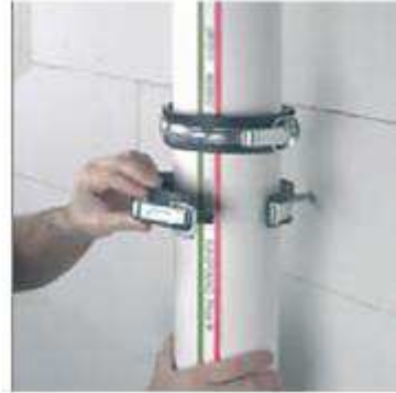
Resim 1.5: PVC boru için metal kelepçenin duvara montajı
