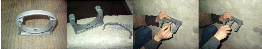
Resim 1.4: Plastik kelepçenin duvara sabitlenmesi
