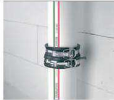
Resim 1.6: PVC borunun metal kelepçe ile sabitlenmesi
