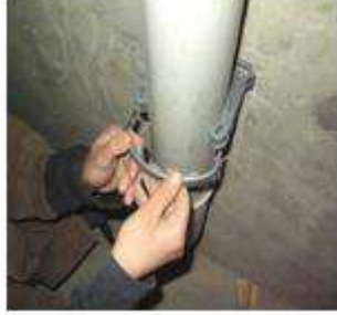
Resim 1.5: PVC borunun plastik kelepçe ile sabitlenmesi
