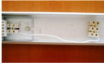
Resim 4.17: Balasta faz kablosunun bağlantısı
