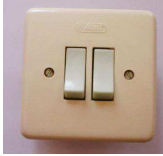
Resim 1.29: Komütatör anahtarın önden görünüşü
