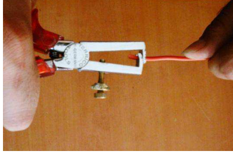
Resim1.43: Kablonun kablo soyma pensi ile soyulması
