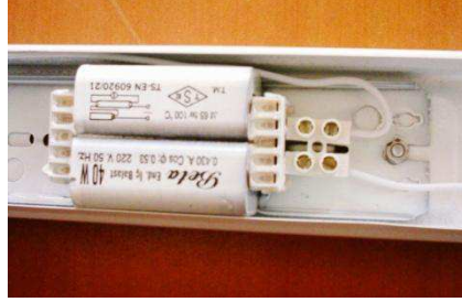
Resim 4.18: Balastın diğerk ucunun bağlantısı
