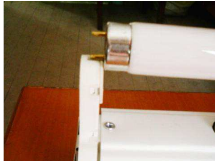
Resim 4.26: Floresan ampulün sokete takılması
