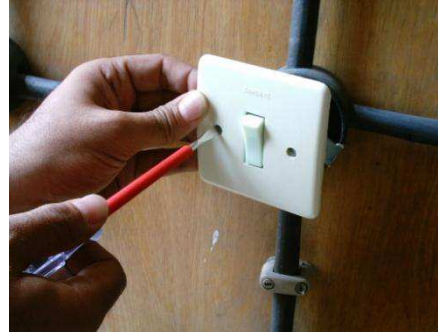
Resim 1.42: Anahtarın kasaya tutturulması
