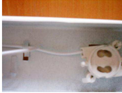
Resim 4.20: Starter socketi bağlantısı
