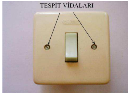
Resim1.22: Sıva altı anahtarın önden görünüşü
