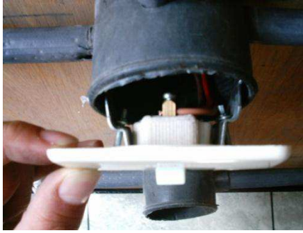
Resim 1.42: Anahtarın kasaya tutturulması
