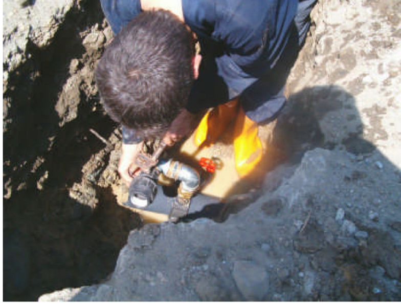
Resim 1.2: Kolye-priz bağlantısı ile şehir şebekesinden su alınması
