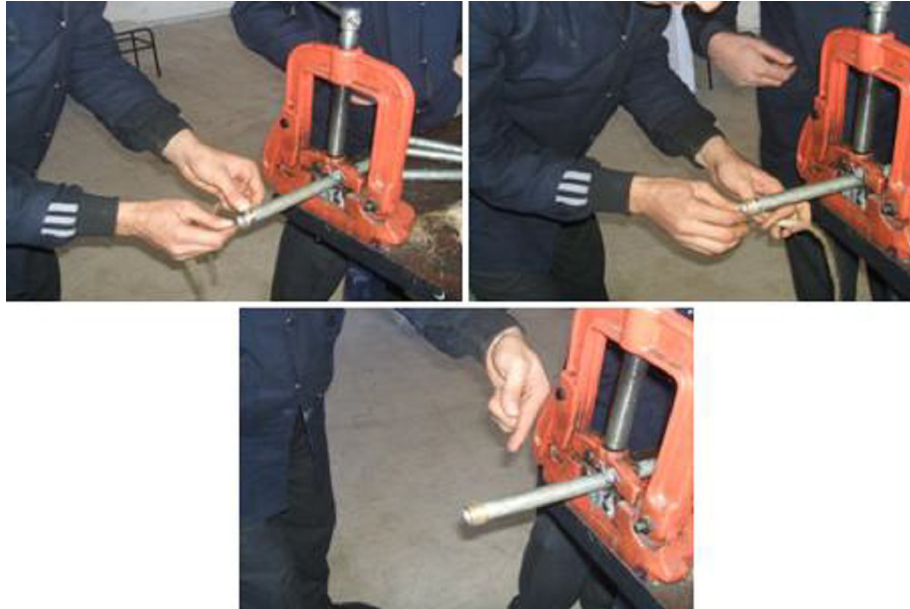
Resim 1.39: Borunun mingeneye sıkıştırılması ve keten (kendir) sarılması
