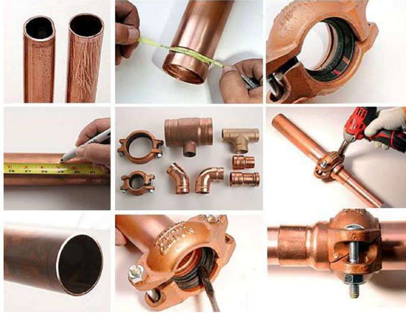
Resim 1.44: Bakır boruların contalı birleştirilmesi
